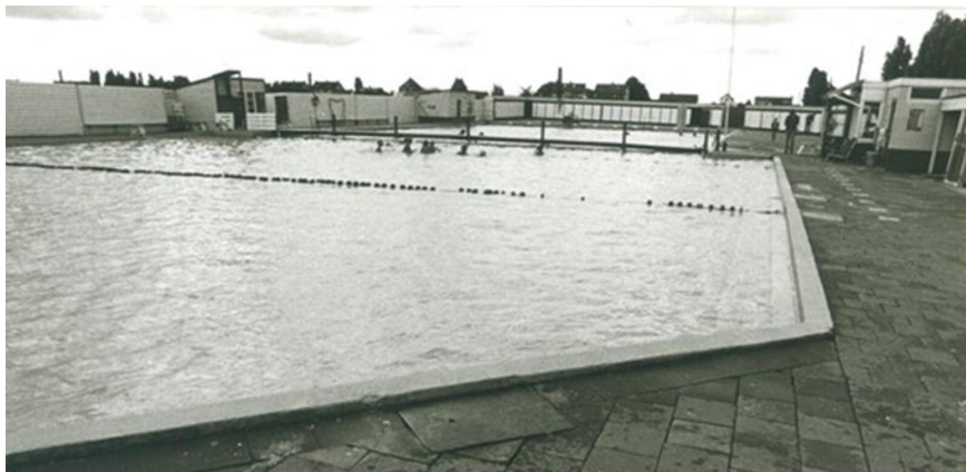
Berkel na de verbouwing
