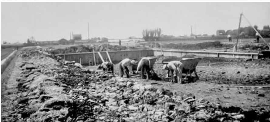
Het grondwerk in Berkel
